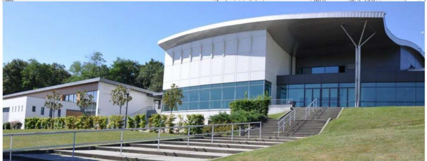
Bâtiment de l'IRIS – 1 Montée des Roches
